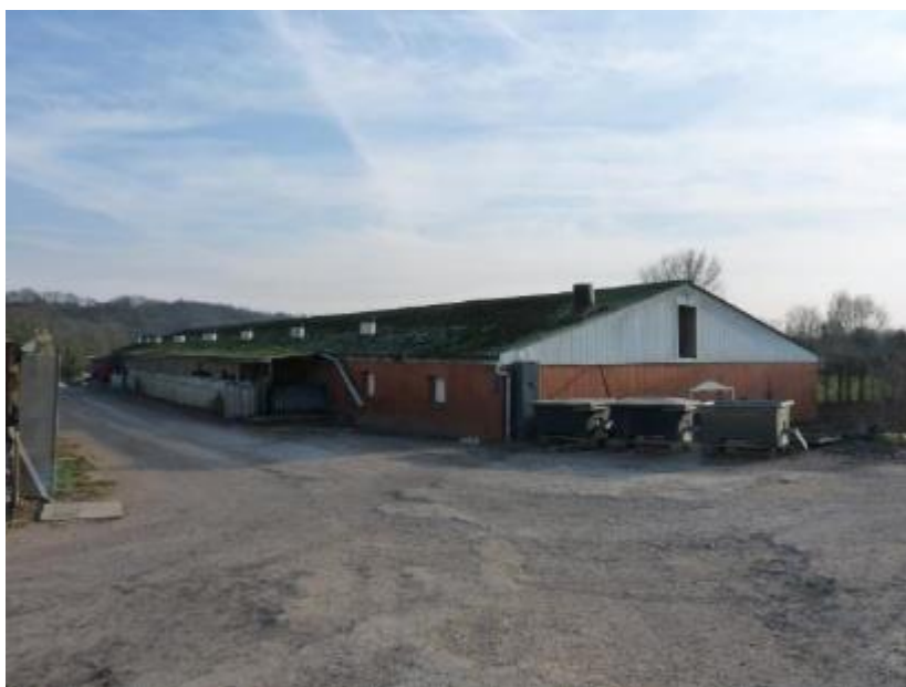
Figure 3. Bâtiment d'élevage porcin P1 – Pignon Nord
